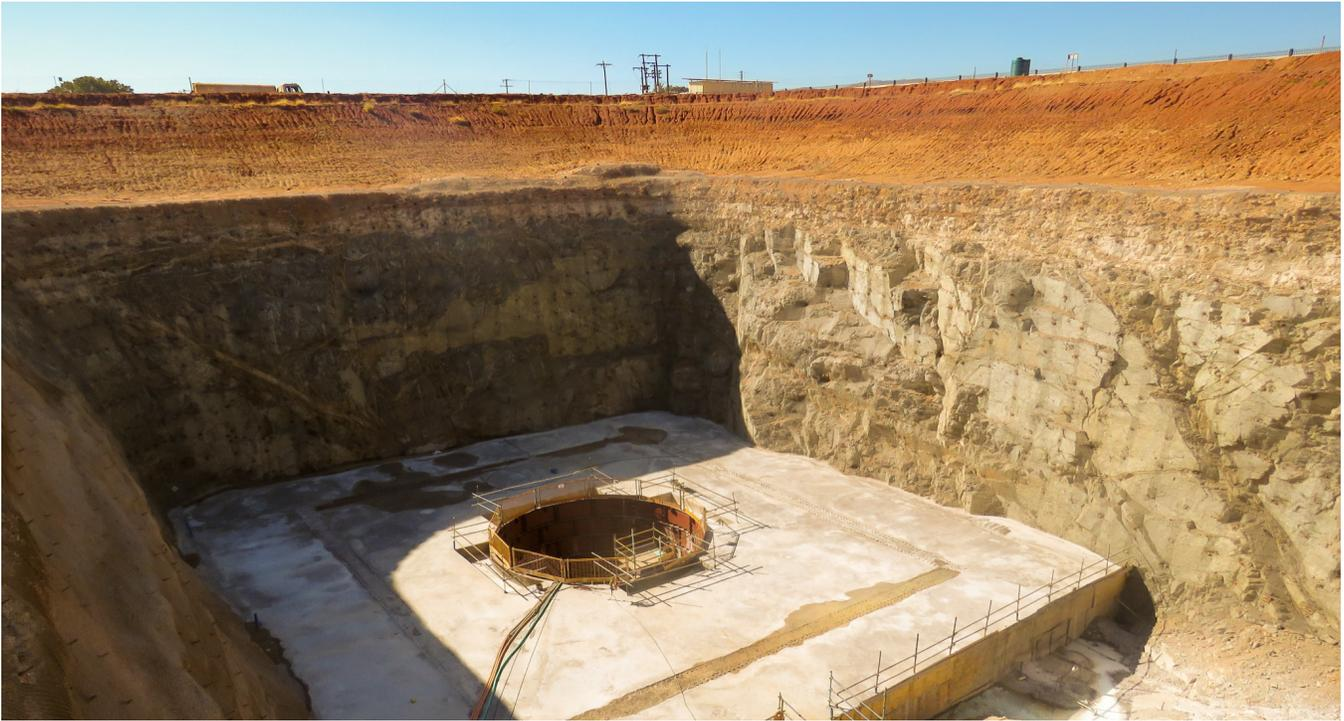
**Test de ventilation à la station de 750 mètres du puits 1. Le puits se trouve actuellement à environ 900 mètres sous la surface. La prochaine station sera à 950 mètres et l'achèvement du puits à une profondeur finale de 982 mètres est prévu pour début 2020.**
