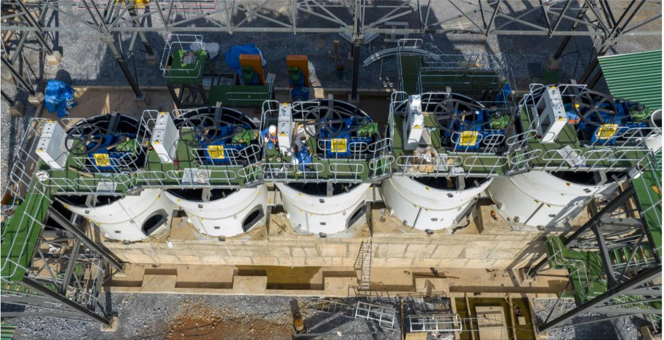
基普什选厂施工现场的鸟瞰图，图片上方绿色位置显示了地表矿石输送系统，将毗邻的 **P5** 竖井连接到矿堆位置。**80** 万吨/年选厂的建设正超计划推进，目前已完成 **76%**，预计将于 **2024** 年第二季度投产。
