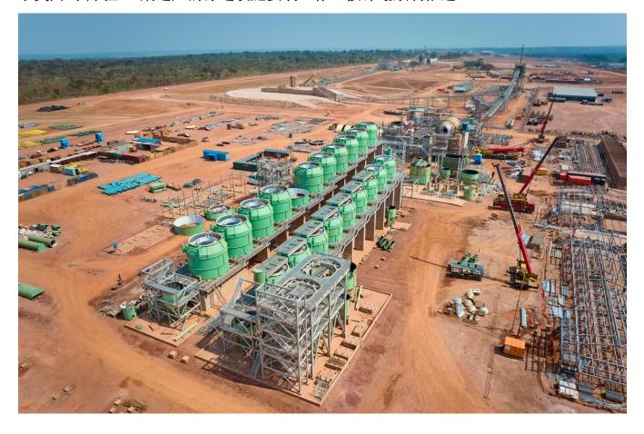
Ⅲ 期选厂现场已开始安装第一台球磨机 (共两台) ,同时正进行浮选设施的安装工作。首批机械设备包括圆锥破碎机、浮选槽、振动筛、精矿压滤机、旋流器、压缩机和水泵等,部分已抵达现场,其余设施也即将交付现场。
