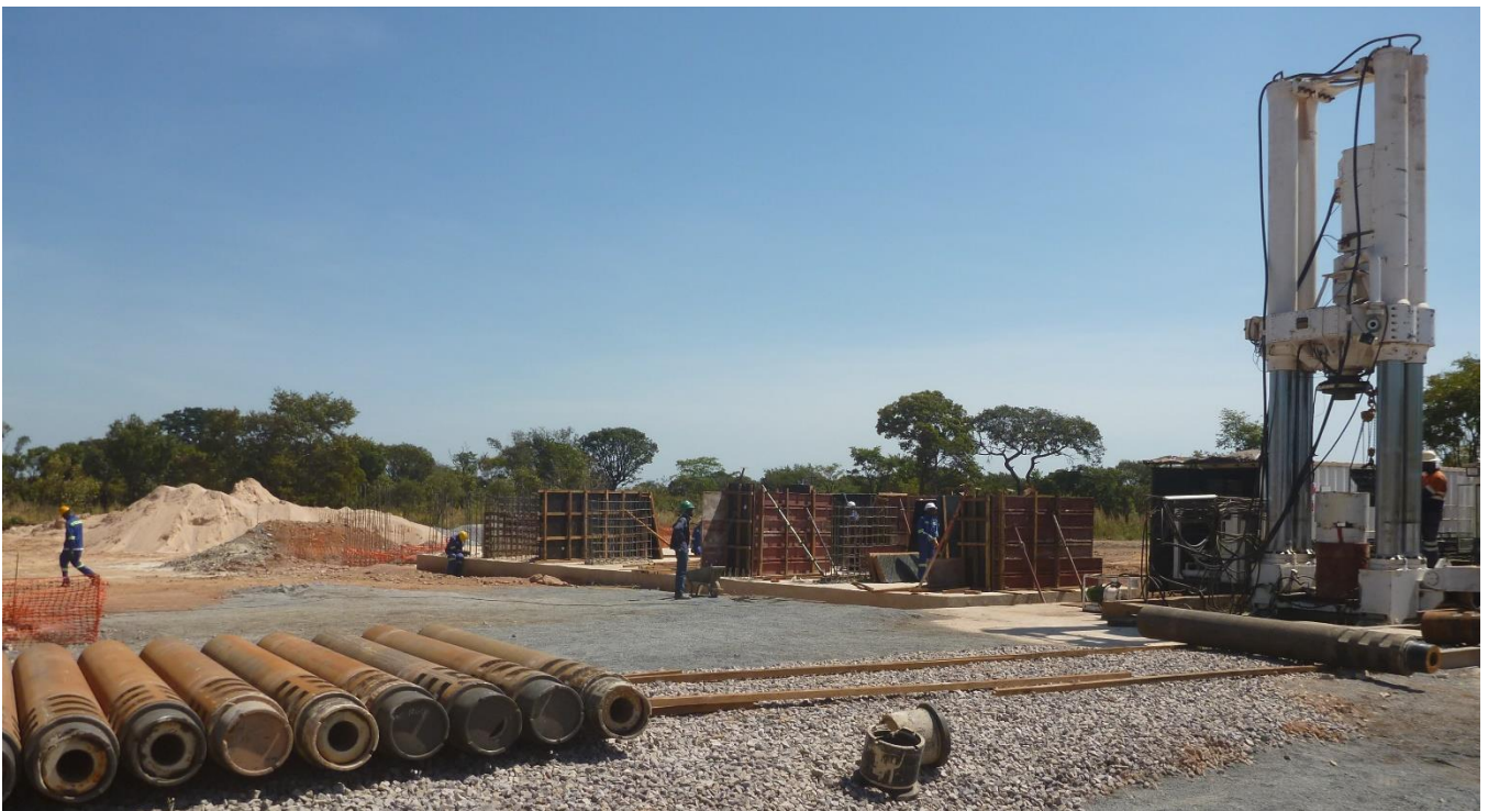
Figure 13 : Une machine de forage en montant en opération au puits de ventilation 1 (à droite), à côté des fondations en béton qui sont construites pour soutenir les ventilateurs à large capacité.
