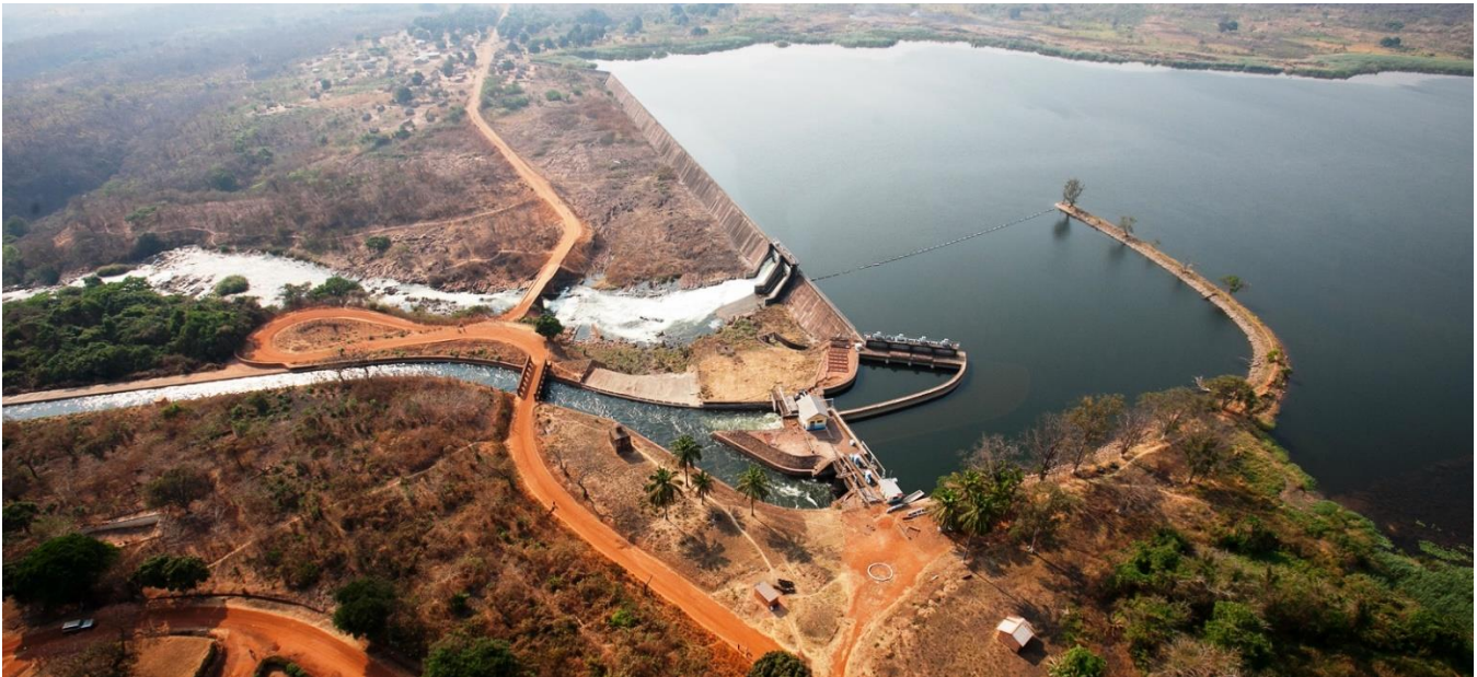
Figure 18 : Modernisation du barrage hydroélectrique de Mwadingusha.
