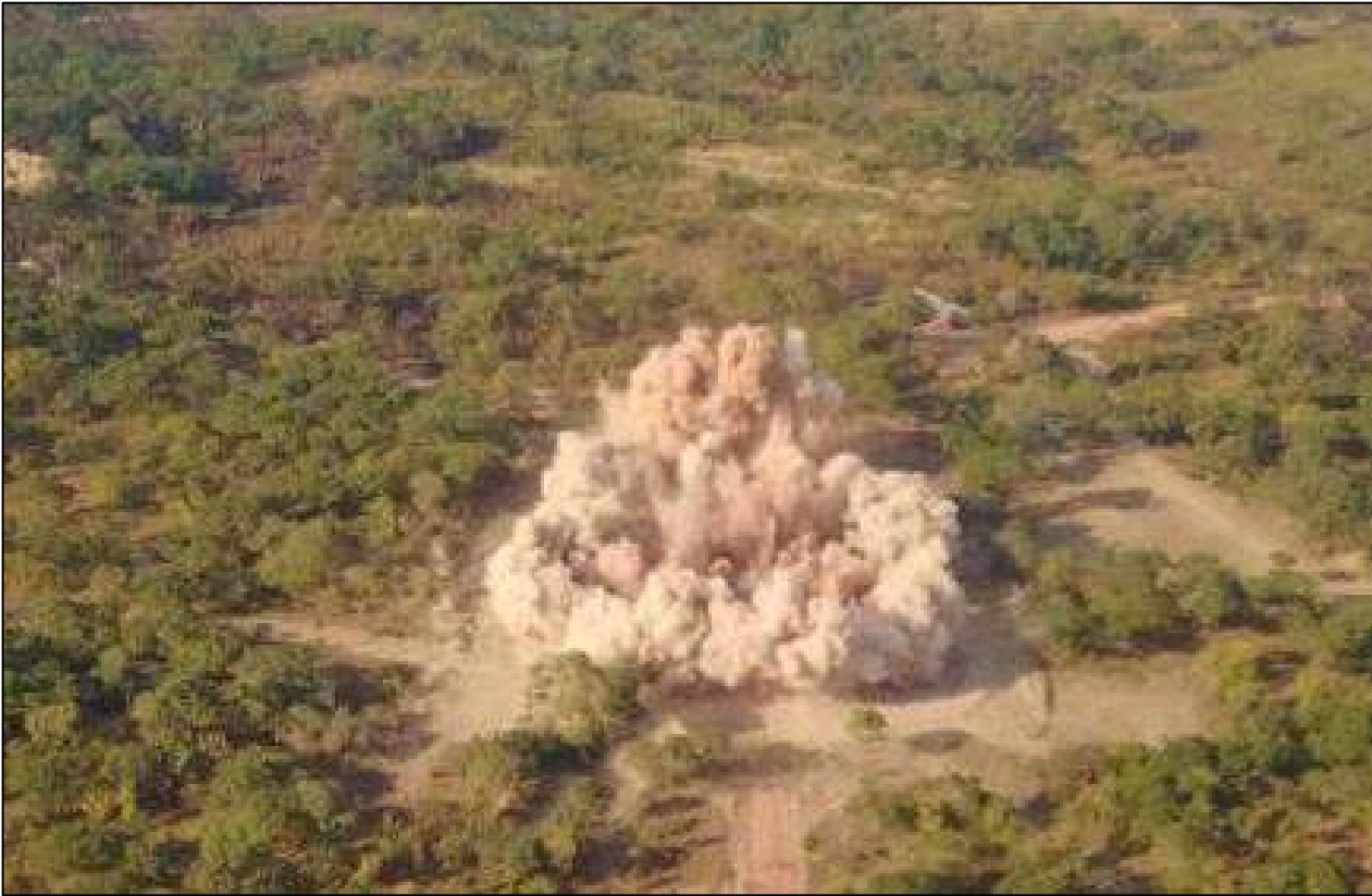
图 11 及 12 : Kakula 箱形挖槽完成首次爆破后, 目前正进行挖掘工程。
