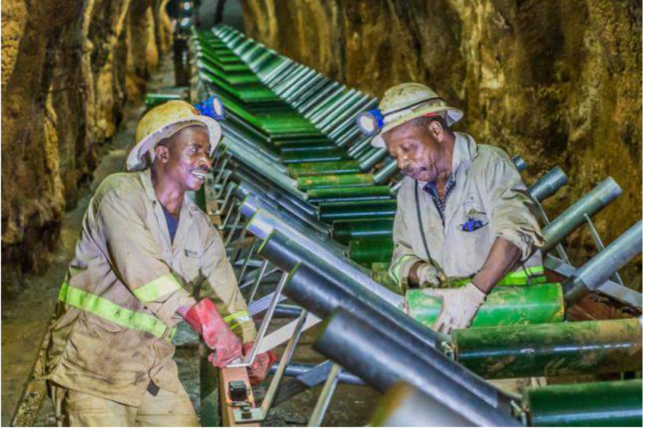
图 6 及 7：在五号矿井的矿石运输系统安装新的输送带滚筒。
